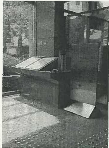
音声での案内がないため、せっかく設置されていても気がつかない(第3庁舎 点字案内板)
