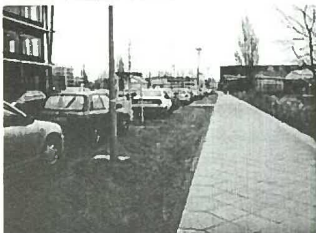
FIG 4-2-7 歩道脇にある雨水浸透のための緑地 ゆるやかな溝になっている。(ベルリン)
