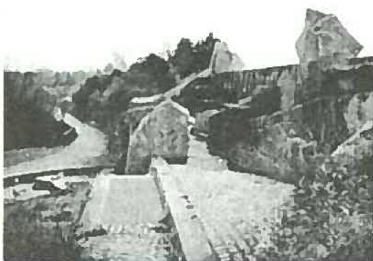
FIG 4-1-7 高速道路上ビオトープの入口
