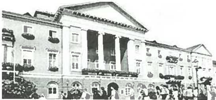
FIG 4-1-3 カールスルーエ市庁舎 (Rathaus) 出典:カールスルーエ市広報誌KARLSRUHE extra 2003
