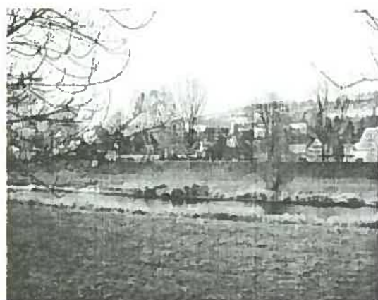
FIG 4-1-17 プフォルツァイム、エンツ川 近自然化後（ドイツ） 堤防を高くするのではなく河川敷を幅広くつくり、背後の緩傾斜堤防も植栽の配置など自然に近くつくられている
