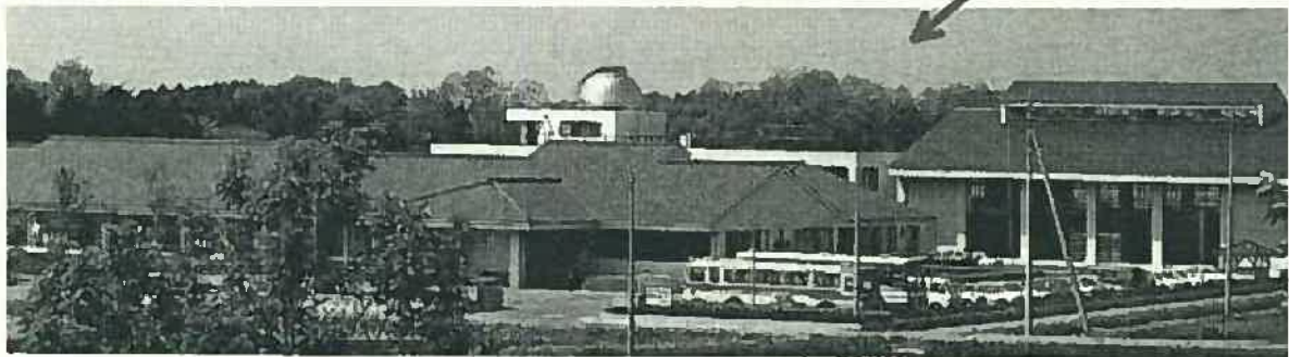
【図2-5】真岡市自然教育センター全景 出典：真岡市自然教育センターパンフレット
