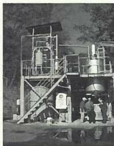
【図3-15】小菅村林業廃棄物処理施設
