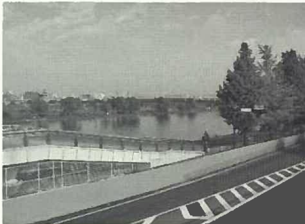
【図3-19】さいわい歩道橋 提供：多摩川施策推進担当
