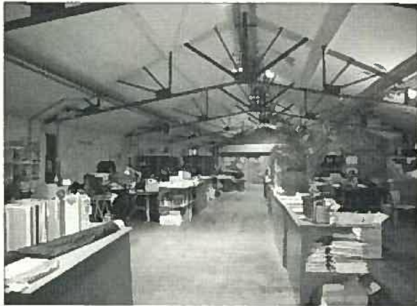
施設最上階フロアの事務室の様子
