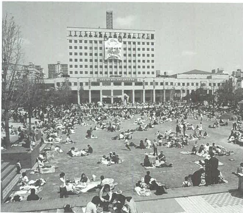
富山市庁舎と庁舎前広場
