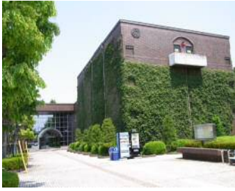
▲ツタの絡まるチャペルではないが趣あり
