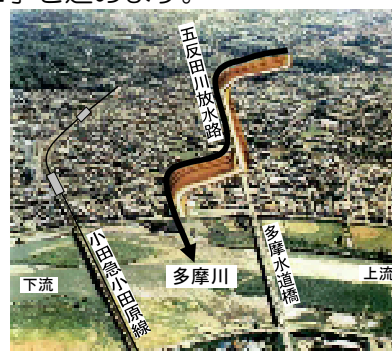
五反田川放水路整備事業
