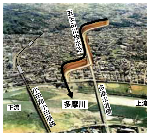
五反田川放水路整備事業
