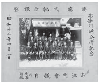
建物エントランス上部には「高津町役場」の文字
