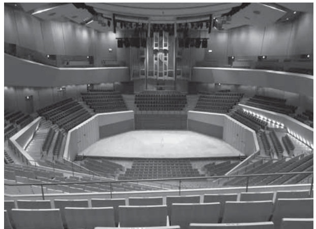
復旧工事完了後のホール(震災前と同形状)
