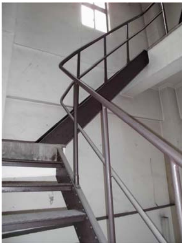
時計塔内部の鉄骨階段（4階より上部）
