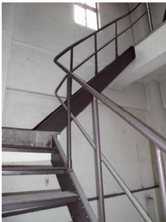
時計塔内部の鉄骨階段（4階より上部）
