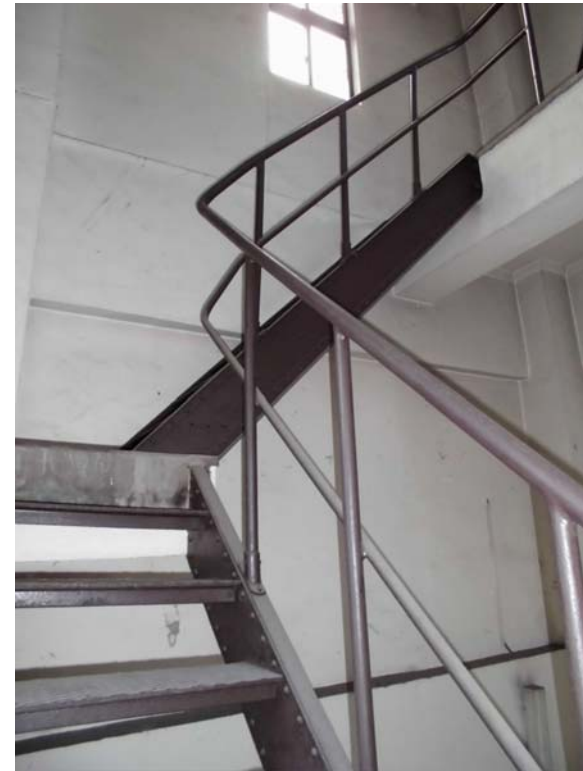
時計塔内部の鉄骨階段（4階より上部）
