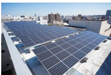
屋上に設置した太陽光発電パネル
