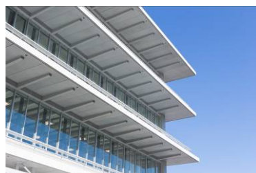
庁舎東側の大庇(おおびさし)
