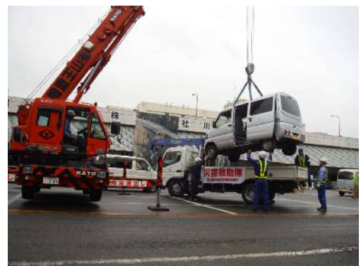
災害時における道路復旧訓練
