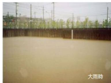
雨水調整池の活用
