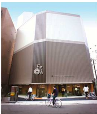
自転車等駐車場(川崎駅東口)
