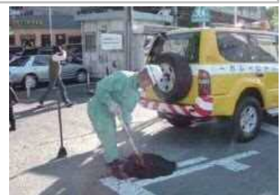
道路維持作業
