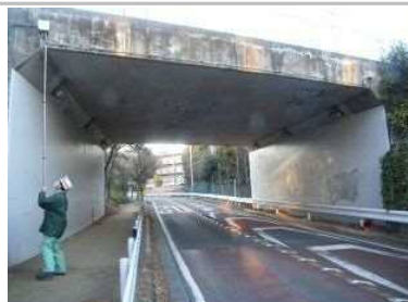
定期点検（橋りょう）
