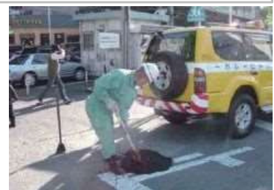
道路維持作業
