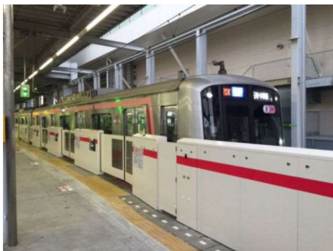
ホームドア（武蔵小杉駅）
