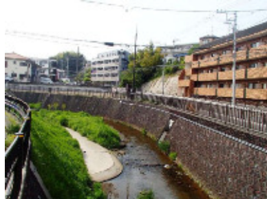
一級河川平瀬川支川 改修事業
