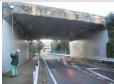
定期点検(橋りょう)
