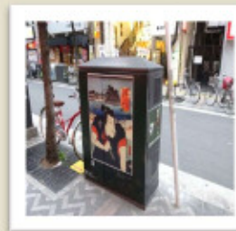
浮世絵トランスボックス
