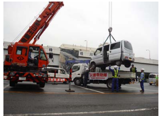
災害時における道路復旧訓練
