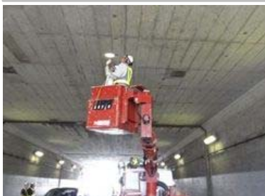
定期点検(トンネル)
