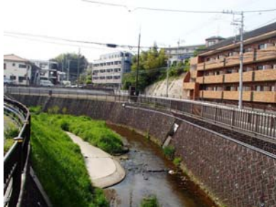
一級河川平瀬川支川 改修事業
