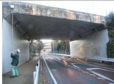
定期点検(橋りょう)
