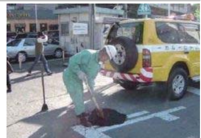
道路維持作業
