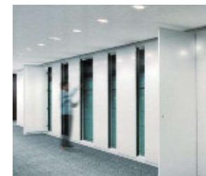
建物の空調や設備機器を収納/遮蔽するパーティション（間仕切り）として、この防音パネル技術を使用。空調や設備機器から発生している騒音が廊下などに漏れ出さないように、この防音パネル技術によって騒音を遮断している。
