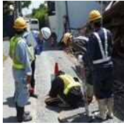
下水管きよ調査
