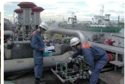
危険物施設の検査
