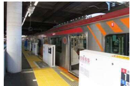
東急大井町線溝の口駅ホームドア
