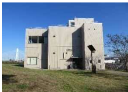
大師河原水防センター
