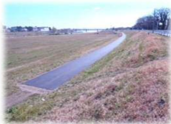
舗装整備箇所
