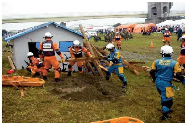
倒壊家屋からの救出救助訓練
