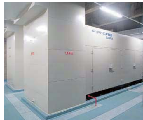
(例) 非常用発電機設置
