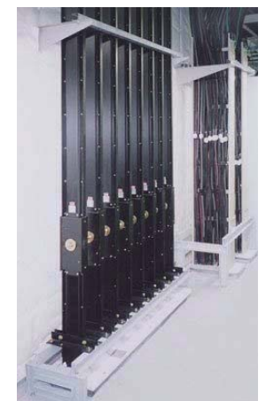
(例) バスダクト設置
