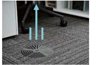
床吹き出し口の一例
