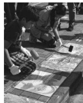
路面啓発シートの設置
