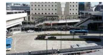
■駅前広場の整備 武蔵溝ノ口南口駅前広場
