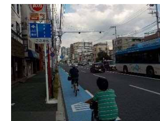
■自転車通行環境整備 (主)東京丸子横浜線
