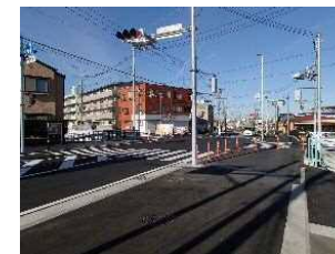
■現道拡幅 (主)川崎府中(生田)
