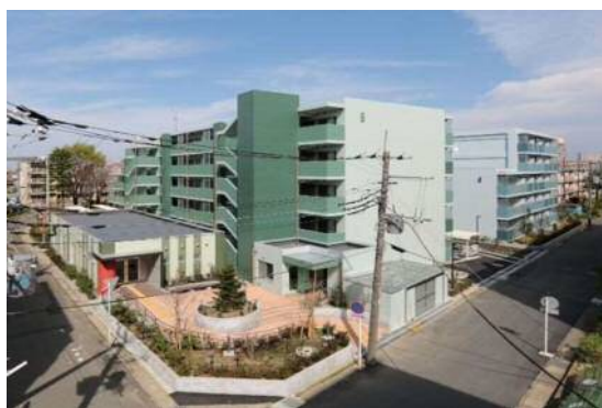
新5号棟、集会所（H27年度竣工）
