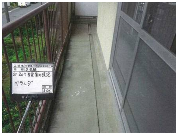
ベランダ・洗濯機置場
