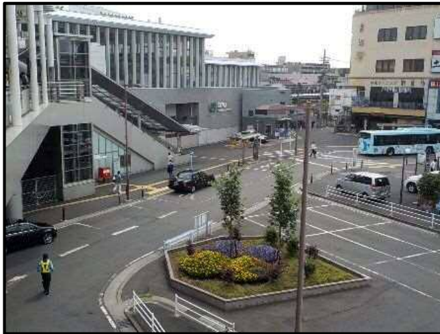
登戸駅の現在の状況 (暫定整備)
