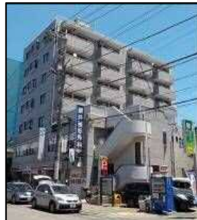
大規模建物 RC造 地上7階(地下1階)
