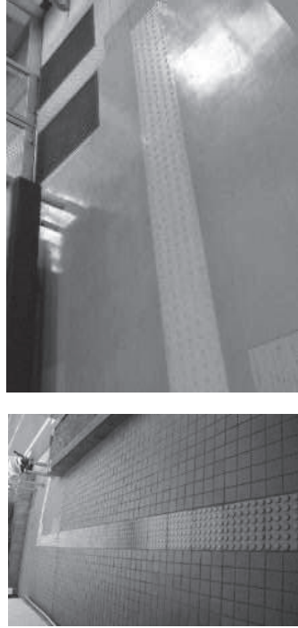
図 31 線状ブロックを敷設すべき位置に点状ブロックを敷設
