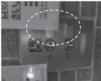
図 26 押ボタンの点字表示が機能していなかった事例(多摩区役所)
