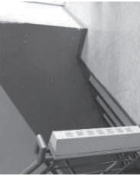
図 40 建物内の階段・傾斜路の上端に点状ブロックがない
