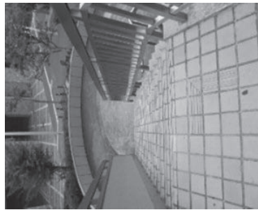
図 39 敷地内通路の階段・傾斜路の上端に点状ブロックがない
