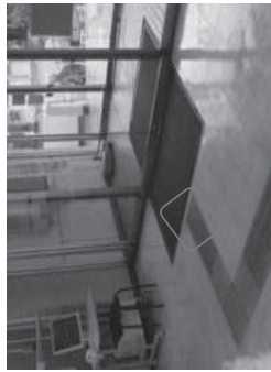
図 32 点状ブロックを敷設すべき位置に線状ブロックを敷設
