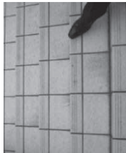
図 24 階段の踏面の端部(段鼻)とその周囲の色が同一
