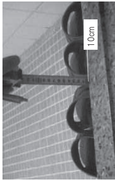
図63 トイレの入口に段差がある
