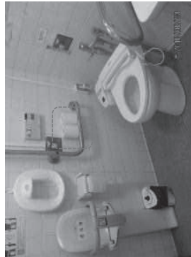
図64 多機能トイレの手すりの使用を妨げる物が置かれている
