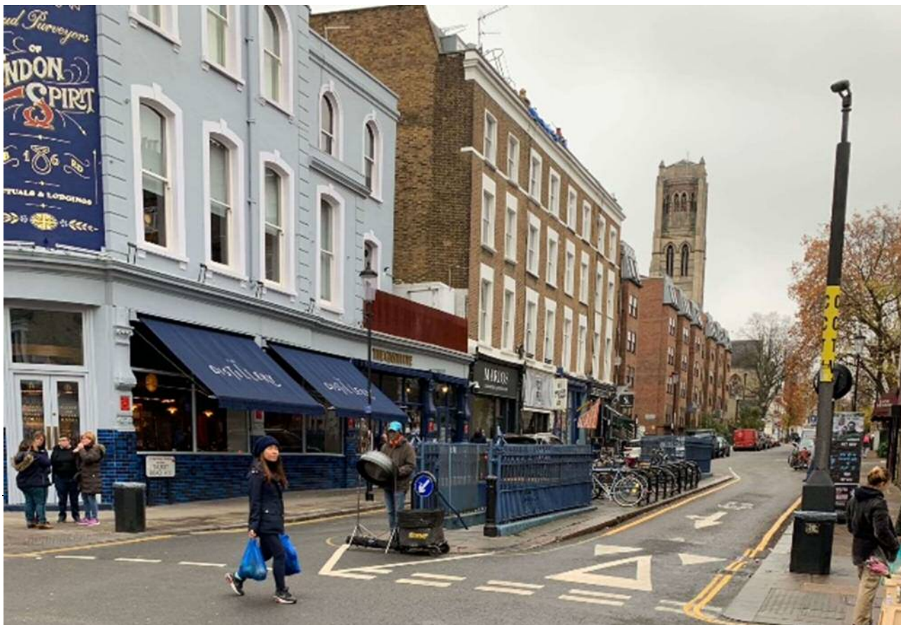
写真 2-14 ポートベローマーケットの地下部分に設置した公共トイレ(地上から)
