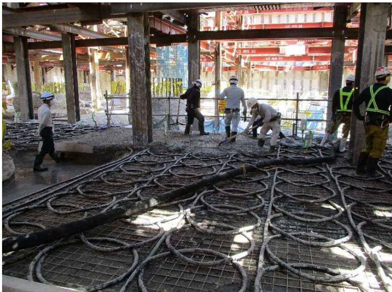
⑨配管の圧力試験が終わった箇所からコンクリートを流して埋めていきます。
