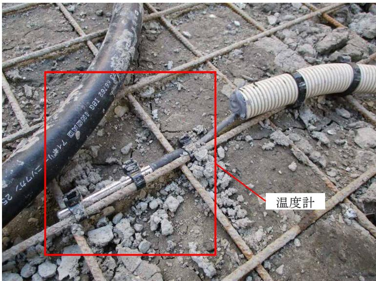
⑦地中温度を計測するための温度計を設置しています。埋設後も地中温度を計測してモニタリングすることができるようになります。
