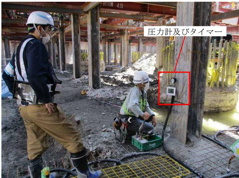
⑧一定程度配管の敷設が完了したら、配管が本当に密閉状態で施工されているか、配管に水を充填し圧力をかけて試験を行います。既定の時間を経過後も圧力が落ちていなかったら、配管がきちんと密閉されているため合格となります。
