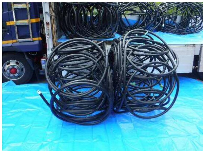
②今回、地中熱に使用する配管は軟質性のポリエチレン管を使用しています。工場で直径800mmの円状になるように固定された状態で納入されます。
