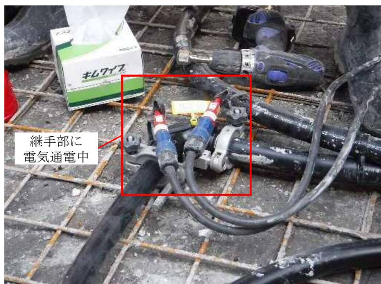
⑥この継手部分に電気を通電し、配管を熱で少し溶かすことで完全な密閉状態で配管を接続することができます。水漏れを防ぐため、継手の密閉接続は重要です。
