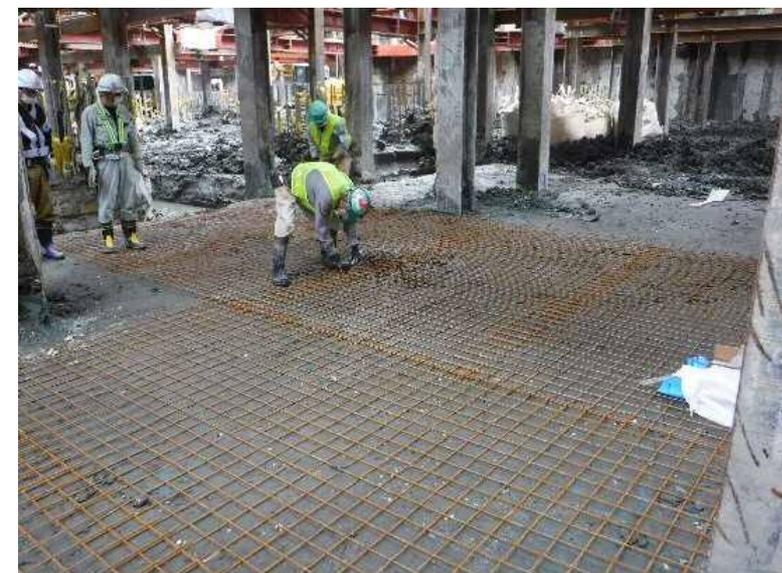
①建築工事にて掘削した地下約14mの最下部に、地中熱配管を固定するための金網を敷いていきます。
