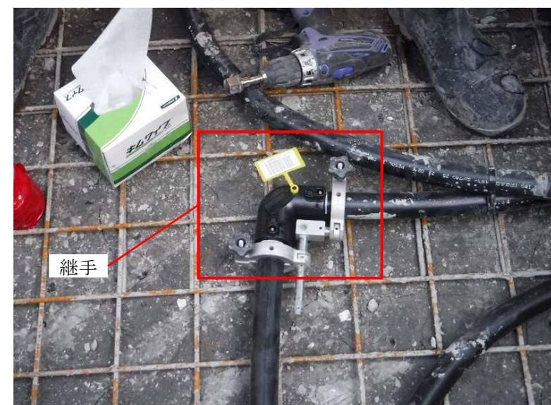
⑤配管が足りなくなったら継手を使用して配管を延長していきます。写真は金具による仮接続状態です。
