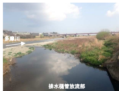
排水樋管放流部
