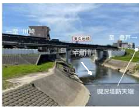
平瀬川との合流部（東久地橋付近）
