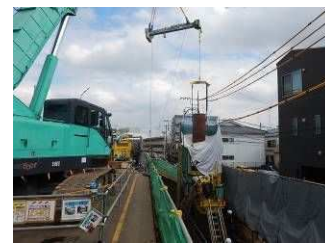
鋼管杭の打設
