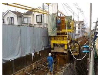
鋼管杭の打設
