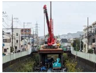
仮設構台の築造
