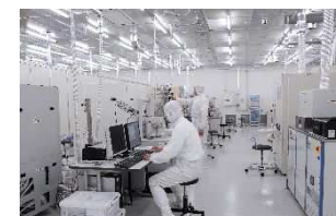
クラス 100・10000 の オープンクリーンルーム
