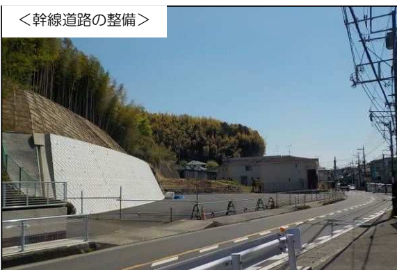
尻手黒川線（Ⅳ期）【擁壁施工中】
