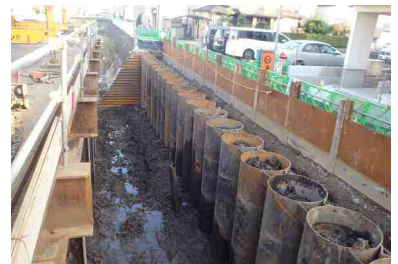
鋼管護岸へ更新中 【市費にて対応】
