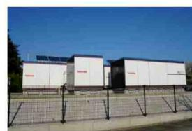
太陽光発電の電気で製造した水素を貯蔵し、燃料電池により平常時や災害時に施設や避難者に対して電力や温水を供給する自立型エネルギー供給システム「H2One」の実証
