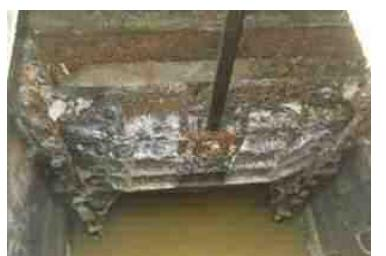
硫化水素による槽内部の劣化
