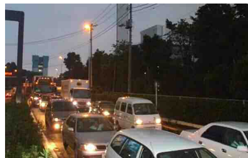
川崎港海底トンネル（川崎方面）
