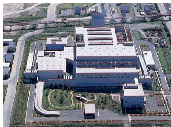
《完成時（H7 年）の浮島処理センター》
