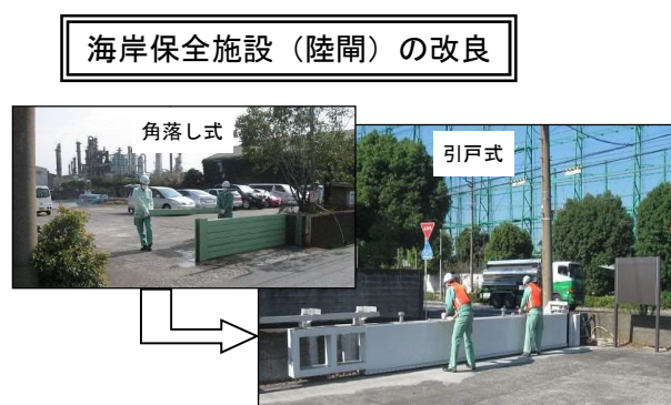
操作性向上による閉鎖作業の時間短縮 および作業員の安全性確保
