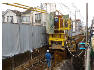
鋼管杭の打設
