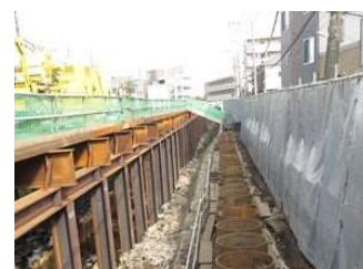
鋼管杭の打設
