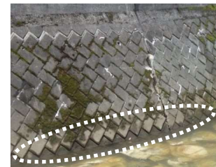
護岸の変状(ブロック隙間の拡大)
