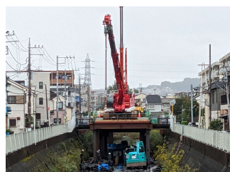
仮設構台の築造
