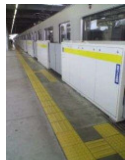
ホームドア設置
