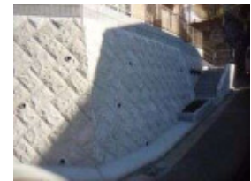
宅地防災工事
