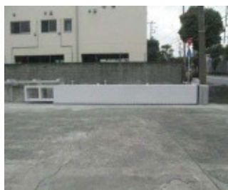
海岸保全施設の改良
