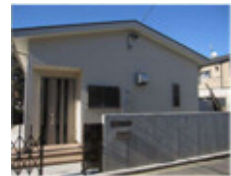
整備後の会館
