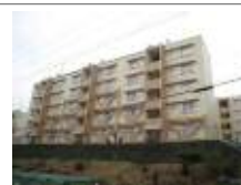
計画修繕：有馬第1住宅（7・8号棟）
