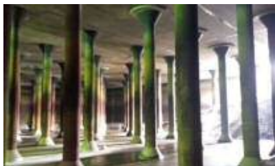
末吉配水池 更新工事
