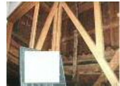
木造住宅の耐震改修工事
