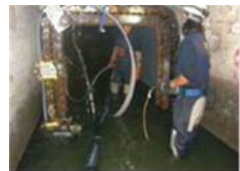
更生工法による再整備
