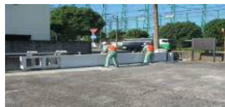
海岸保全施設の改良
