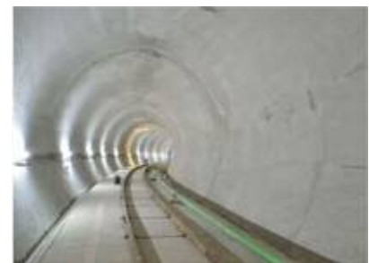
大師河原貯留管の整備
