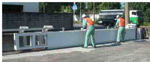
海岸保全施設の改良
