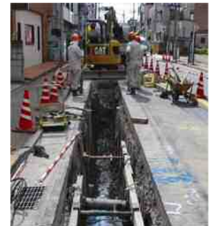
耐震管布設工事
