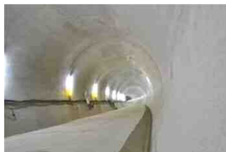
大師河原貯留管の整備
