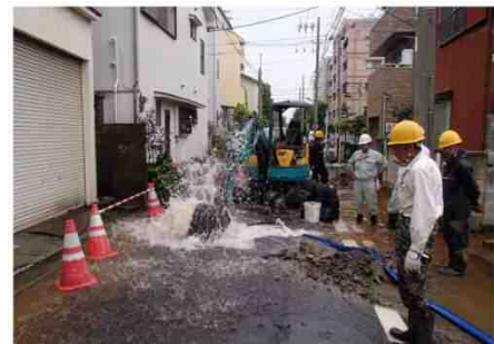
漏水修理工事
