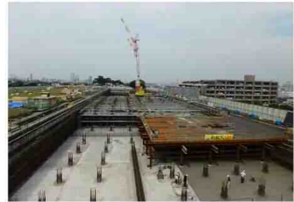
末吉配水池 更新工事
