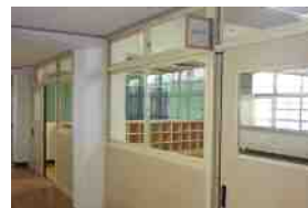
再生整備実施（第1期）：御幸中学校
