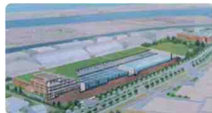
入江崎水処理センター西系再構築
