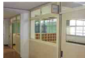
再生整備実施（第1期）：御幸中学校
