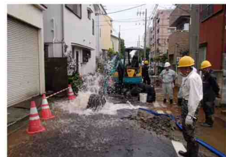
漏水修理工事
