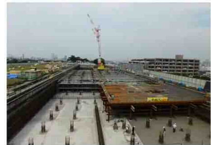
末吉配水池 更新工事
