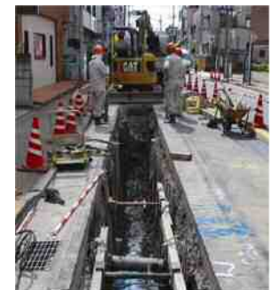
耐震管布設工事
