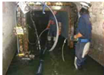
更生工法による再整備
