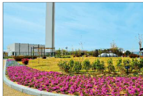
(王禅寺処理センター)
