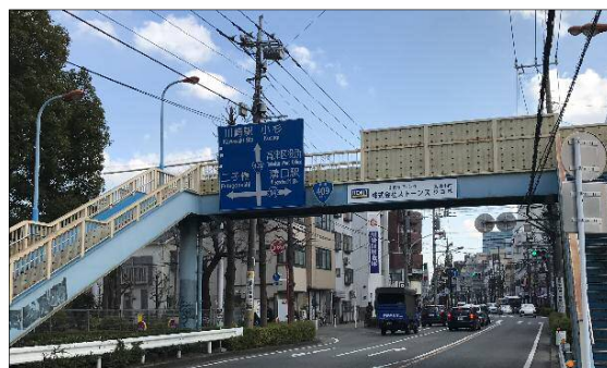
(株式会社ストーンズ高津小前歩道橋)
